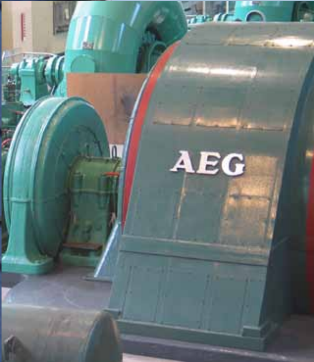
Wasserkraftgenerator mit sinusförmiger Spannung
