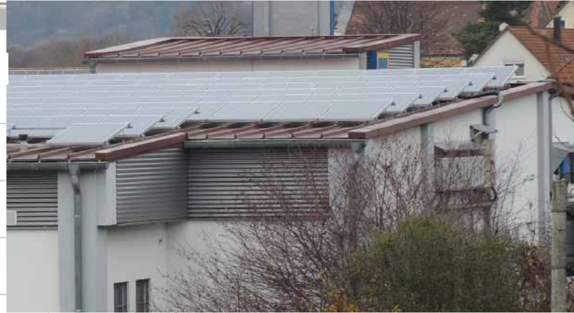
Fotovoltaik auf Supermarkt
