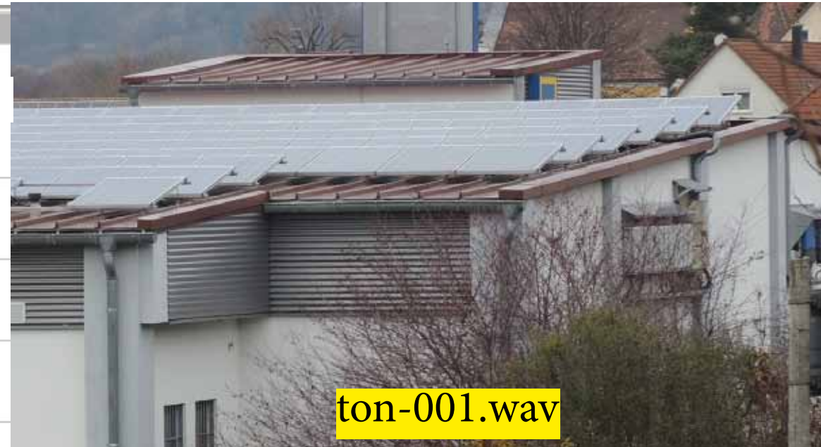
Fotovoltaik auf Supermarkt
