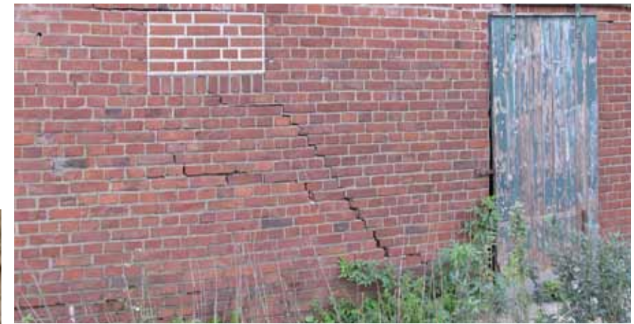
Deutlich sichtbar: Bergschaden
