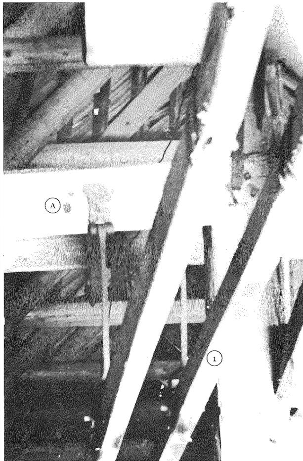
Abb. 85: Aufhängung des Steuergestänges in der Seiltrift der Grube Silbersegen (aus Abb. 86).
