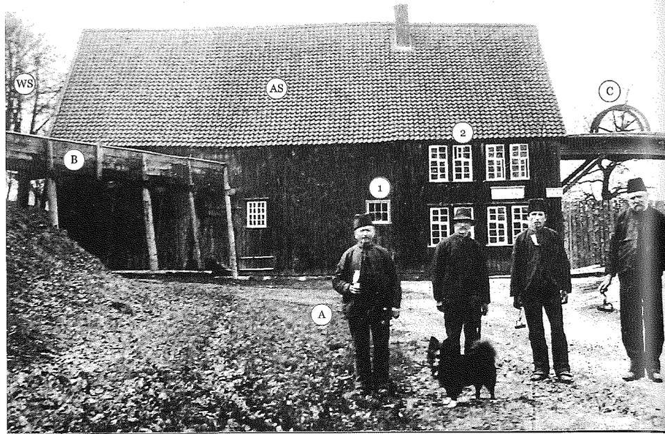
Abb. 41: Kehrradstube der Grube Alten Segen mit Gefluder und Bock mit Seilscheiben über dem Schacht (Harzbibliothek).
