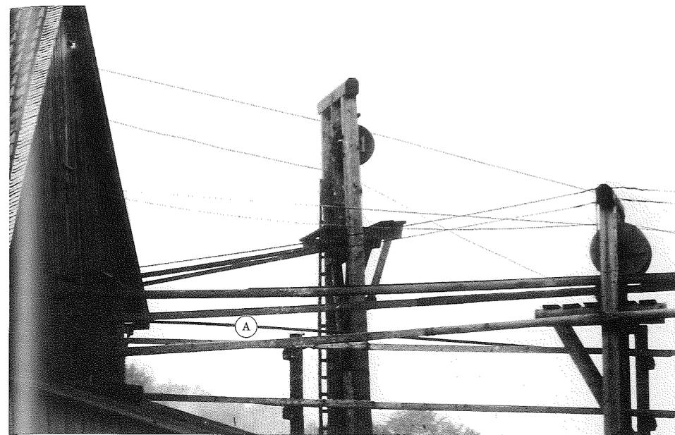
Abb. 91: Seiltrift mit Treibstangen für Radsteuerung und Weiszeug, die Förderseile haben unterschiedliche Spannung (aus Abb. 80).
