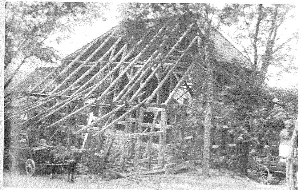
**Abb. 50:** Abriss des Schachthauses der Grube Silbersegen (Sammlung Seidel [47]).
