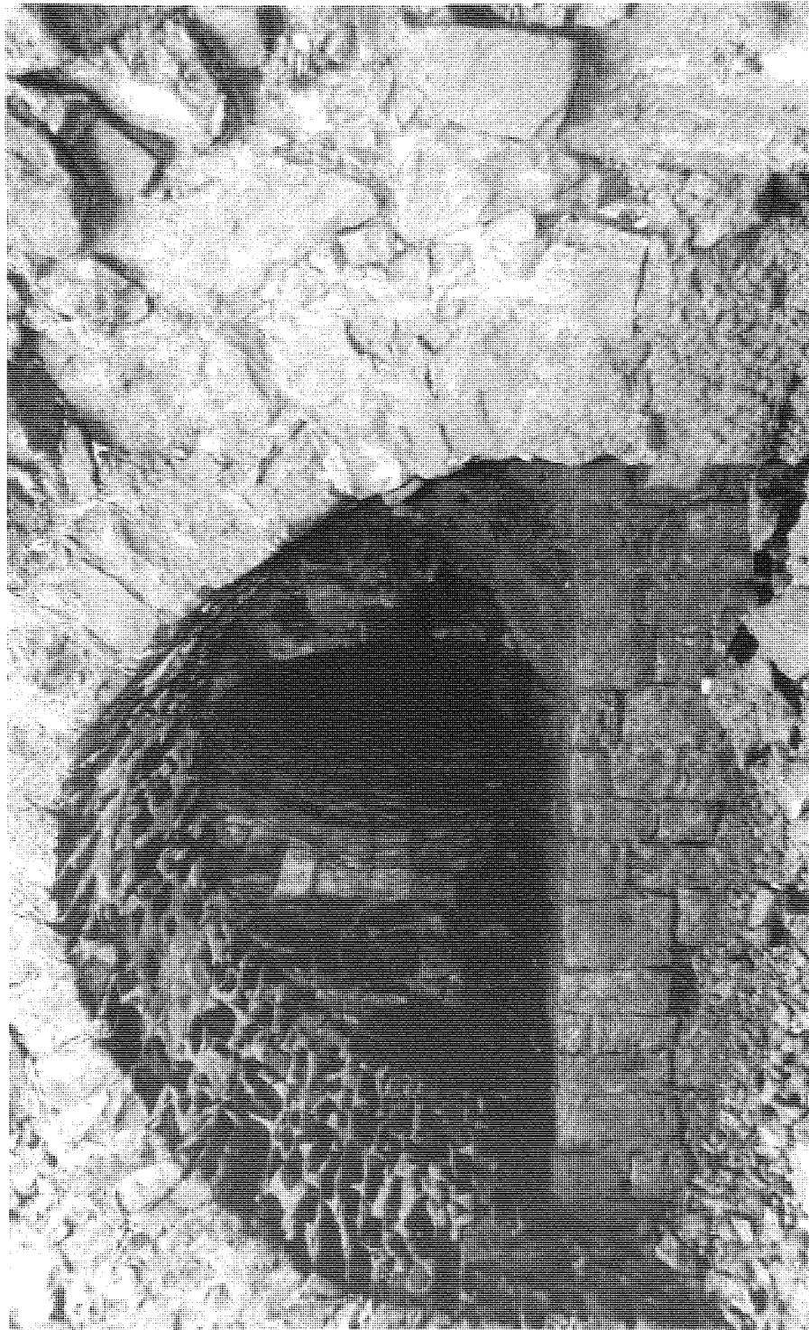
Abb. 16: Ehemalige Seiltrift mit Zugangsstollen. In der hinteren Mauer sind Auflagenflächen für schwere Holzkonstruktionen.
