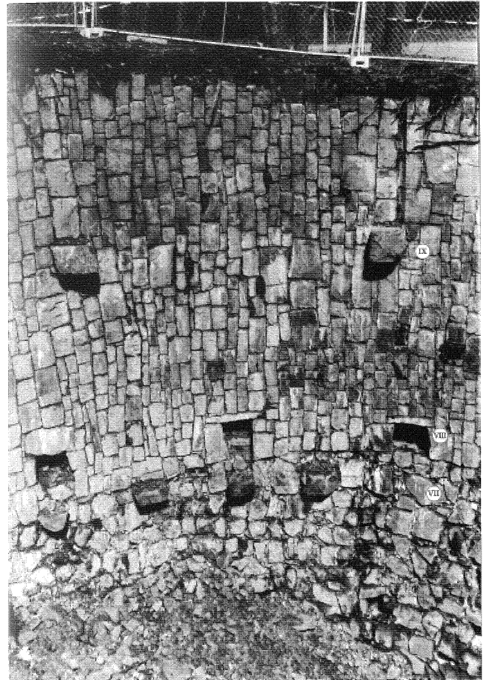
Abb. 8: Kunstvolle Ausmauerung im oberen Teil.
