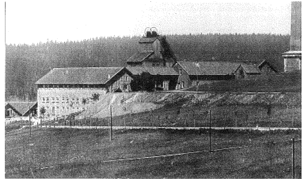
Abb. 43: Gebäude am Otiliae-Schacht – Fördergerüst, Kesselhaus, Kohlenschuppen, Schornstein und Steinbrecher. (Harzbibliothek)
