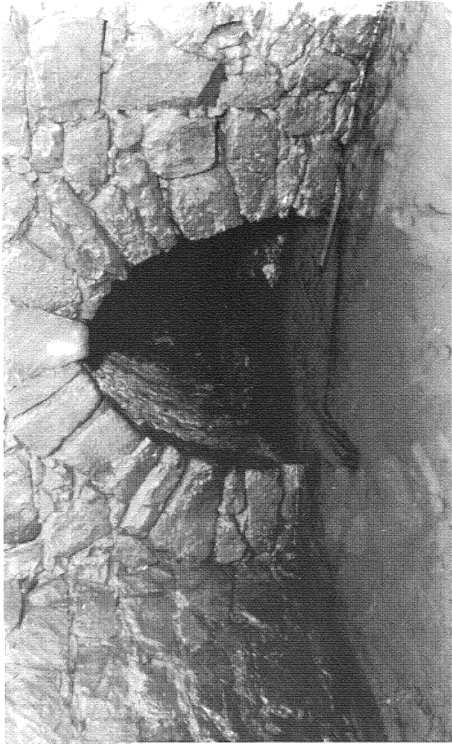
Abb. 14: Die Ablaufrösche ist am Beginn ausgemauert. Unten im Wasser liegen Reste des Tretwerks.
