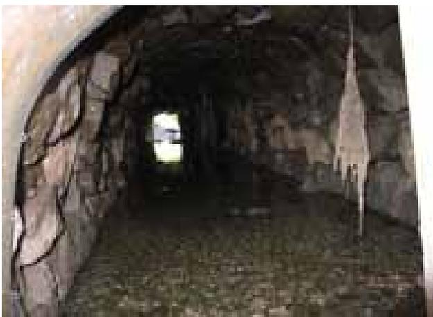
Abb. 2.2.2-15: Überwölbter Graben unter der Altenauer Straße zum Schinderloch
