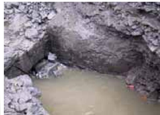
Abb. 2.2.2-16: zugesetzter Abzweig des Bauhofgrabens G 6
