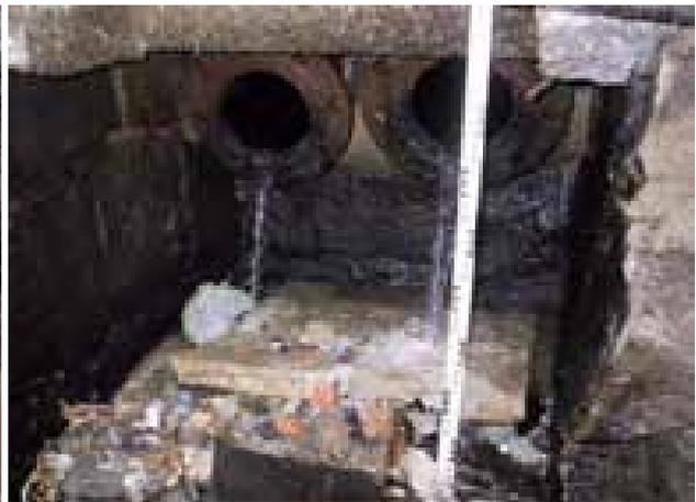
Abb. 2.2.2-14: Fallrohre vom Betongraben G 3 in den Graben unter der Altenauer Straße
