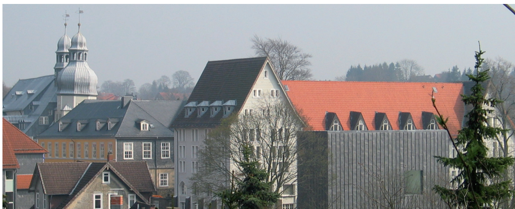
Abb. 1: Die Marktkirche in Clausthal, davor die Gebäude vom Oberbergamt (heute: Landesamt für Bergbau Energie und Geologie, rechts vorne mit der Bleifassade: das Niedersächsische Bergarchiv, eröffnet 2003.
