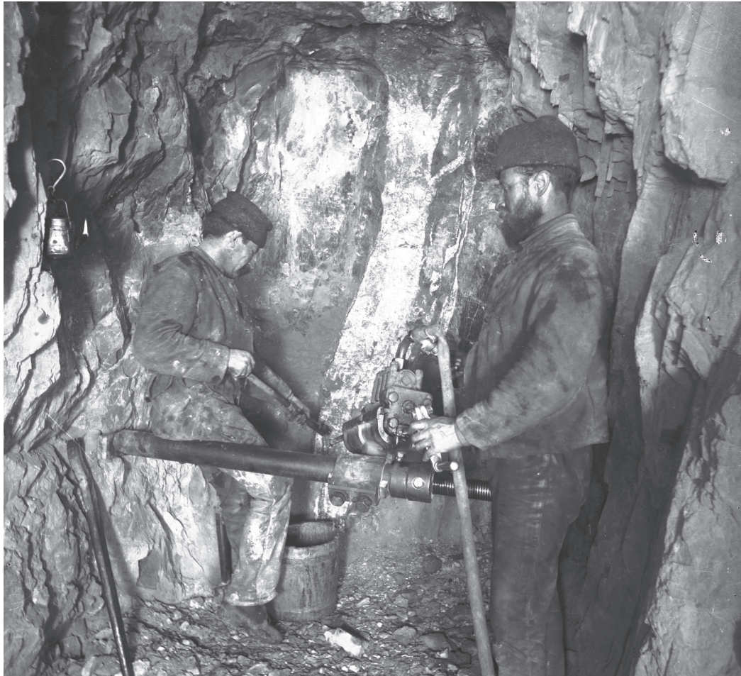
Abb. 9: Vor Ort. Mit einem Preßlufthammer wird der schmale Erzgang abgebaut.
