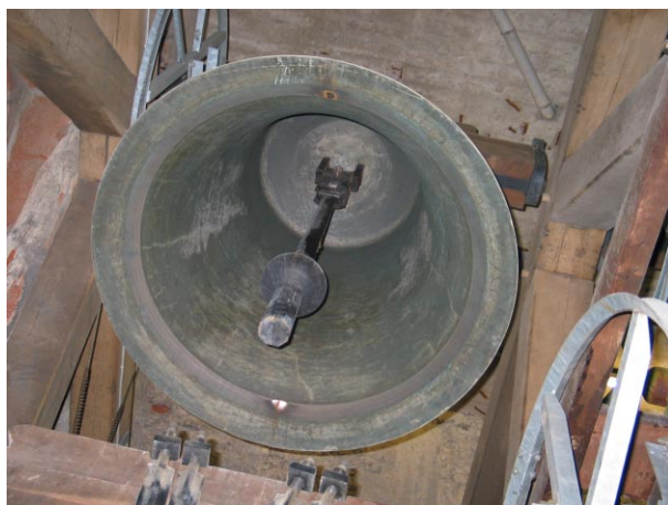
Abb. 9: Blick in eine Glocke, sichtbar die Aufhängung des Klöppels und leichte Abnutzungserscheinung am Schlagring der Glocke
